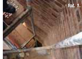
Rys. 8. Elementy pomostu roboczego wykonane z odpowiednio usztywnionych profili
