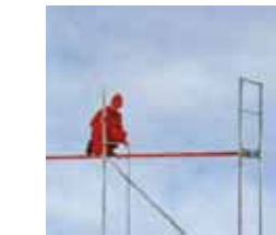
Rys. 4. Zabezpieczenie pomostów najwyższej kondygnacji przed wyparciem – zastosowanie górnego zabezpieczenia podestu lub słupka L
